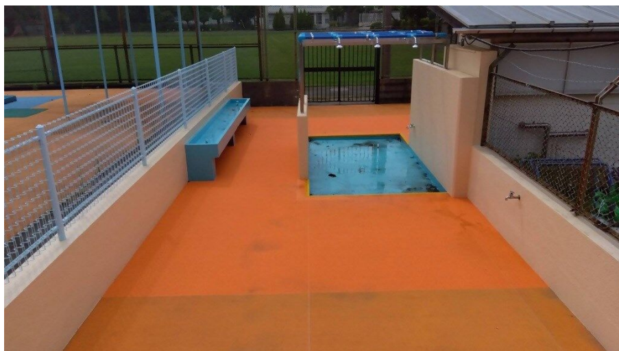
小金井第二小学校プールシャワー壁等改修工事
