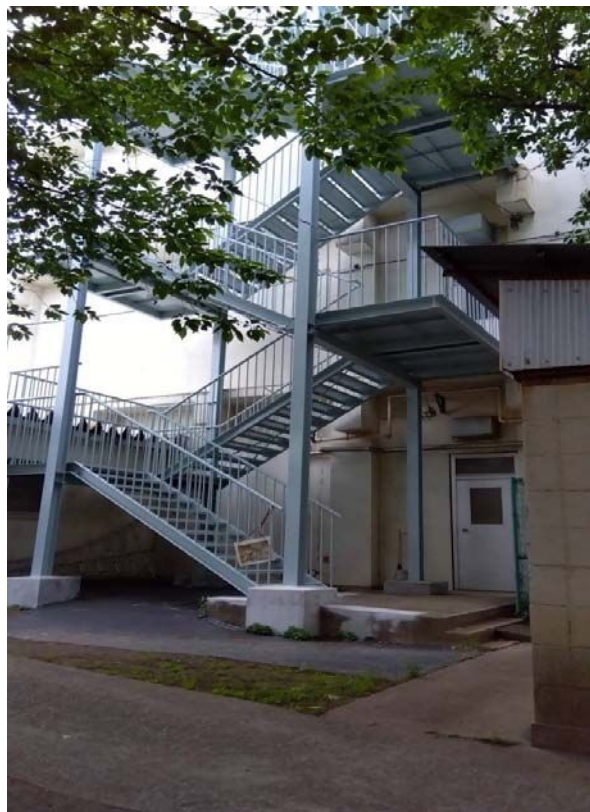
小金井第二中学校屋外鉄骨階段改修工事
