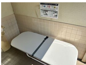
梶野公園のトイレ整備
